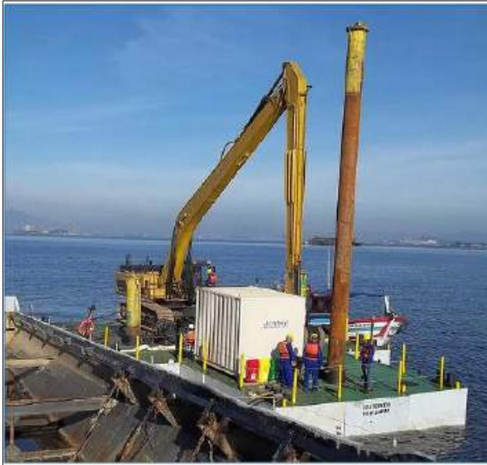
Figura 64. Draga mecânica do tipo *backhoe* estabilizada sobre um flutuante diretamente sobre a lâmina d'água.
