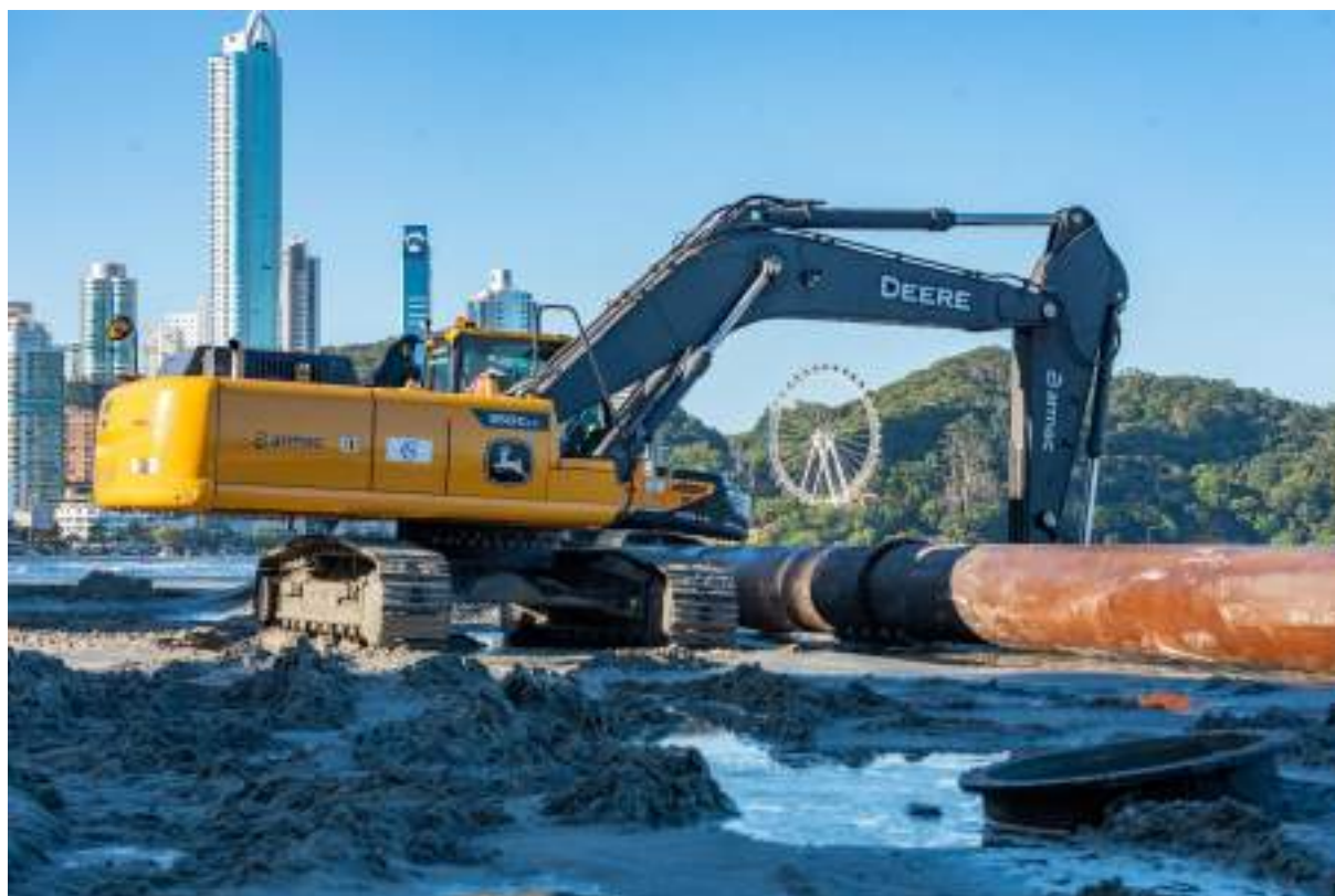
Figura 107. Escavadeira posicionando a tubulação na praia. Foto: Rodrigo Luft.
