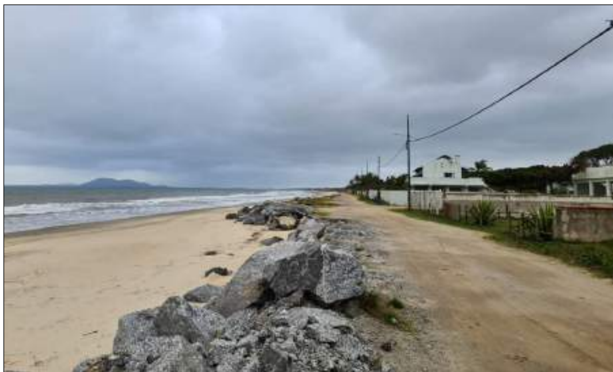
Figura 26. Região com processos de retração da linha de costa e rochas na praia no bairro Princesa do Mar no início do trecho Praia 3.
