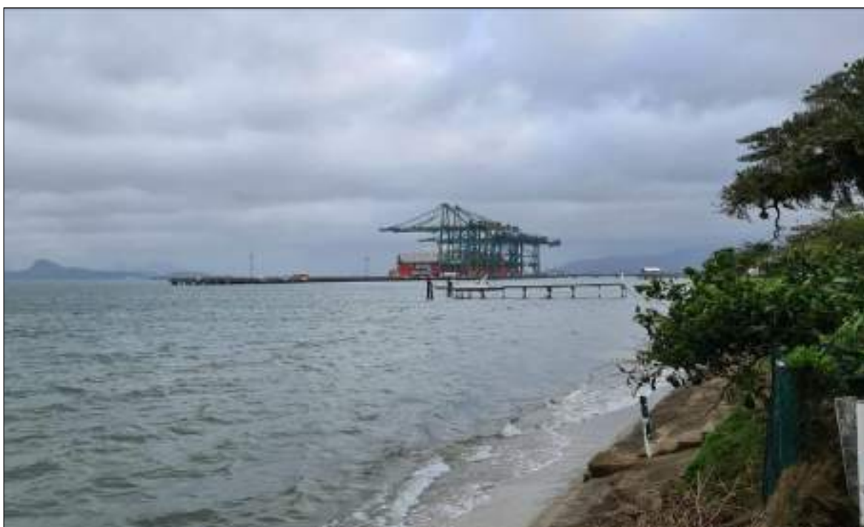
Figura 20. Região com erosão a jusante do Porto Itapoá pertencente ao trecho Praia 1 observando-se a proteção de parte da praia com concreto.
