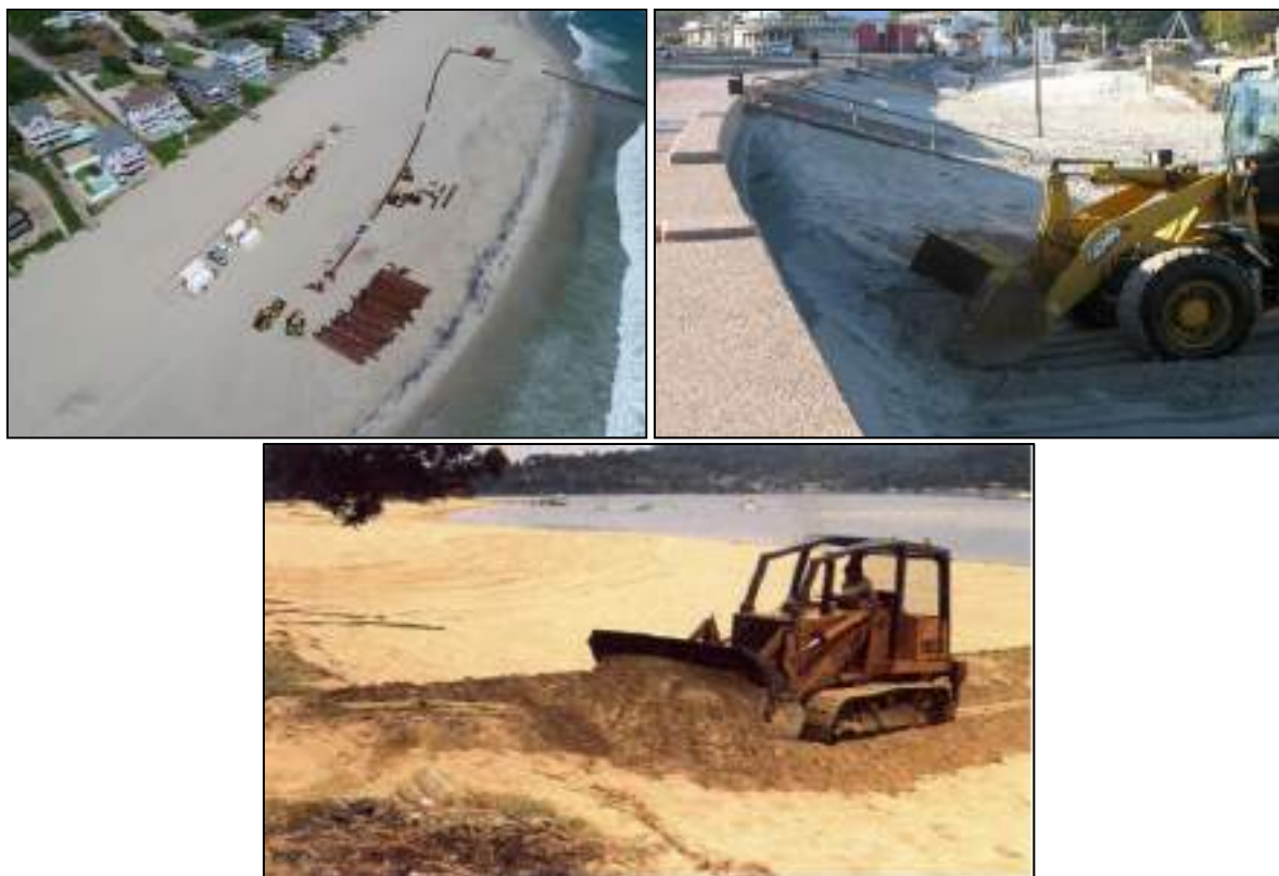
Figura 56. Exemplo de processo de alimentação artificial, mostrando a linha de recalque em terra para a distribuição de areia ao longo do perfil praiado desejado (à esquerda) e retroescavadeira atuando na distribuição de sedimentos na faixa de praia (à direita e abaixo).
