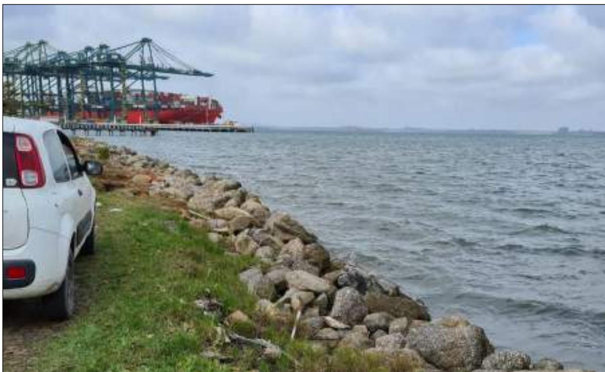
Figura 18. Rochas colocadas para conter a erosão na região a montante do Porto Itapoá pertencente ao trecho Praia 1.
