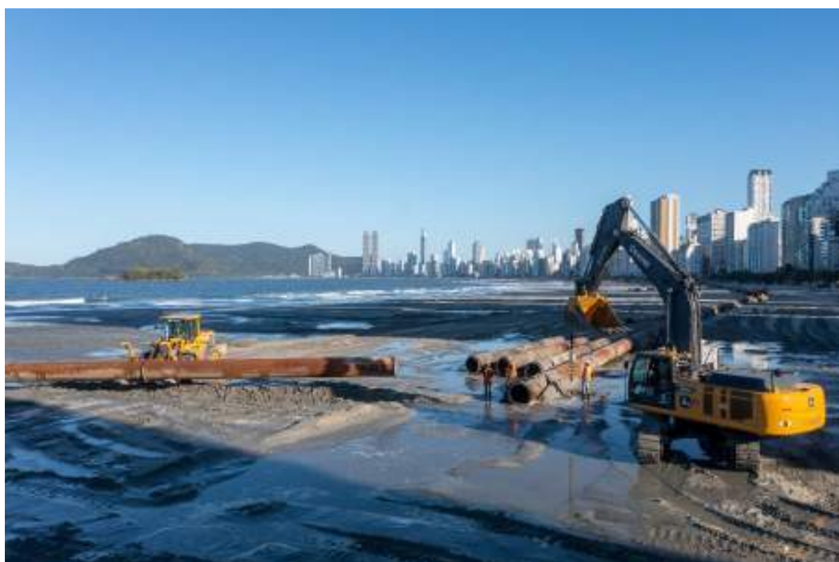
Figura 108. Carregadeira transportando a tubulação na areia da praia. Foto: Rodrigo Luft.
