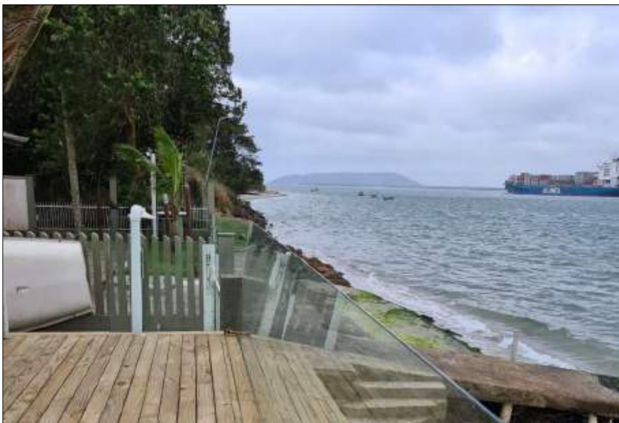
Figura 19. Região com erosão a jusante do Porto Itapoá pertencente ao trecho Praia 1.
