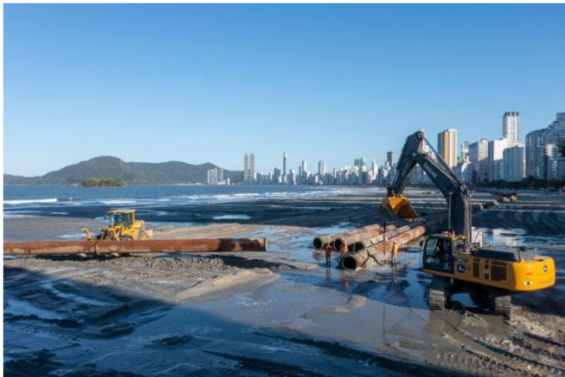
Figura 32. Carregadeira transportando a tubulação na areia da praia. Foto: Rodrigo Luft.
