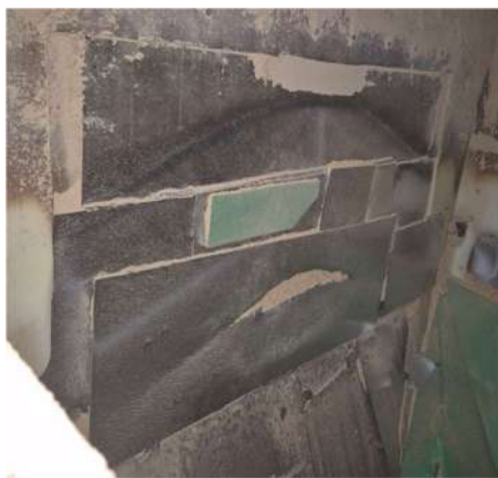
INTERNO CHUTE TRANSFERÊNCIA, FACE ELETROÍMÃ.
