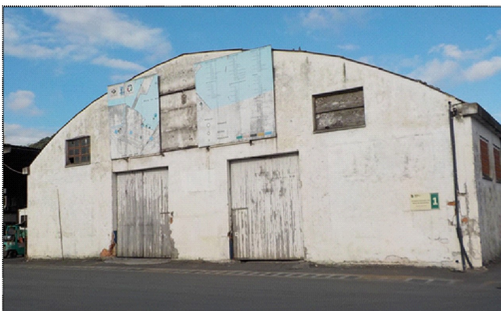
Figura 73 – Galpão / Antiga Oficina
