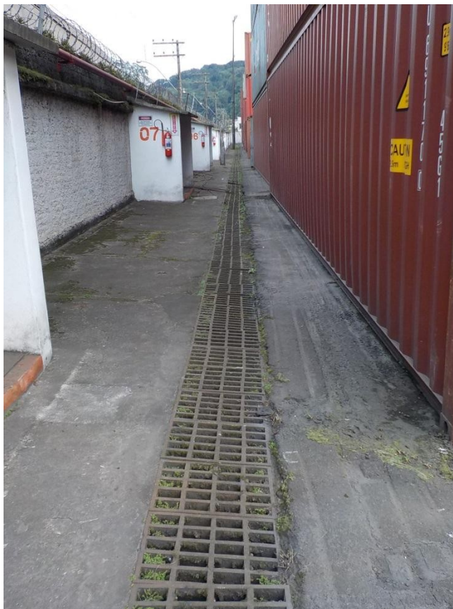
Figura 24 – Canaleta de Drenagem
