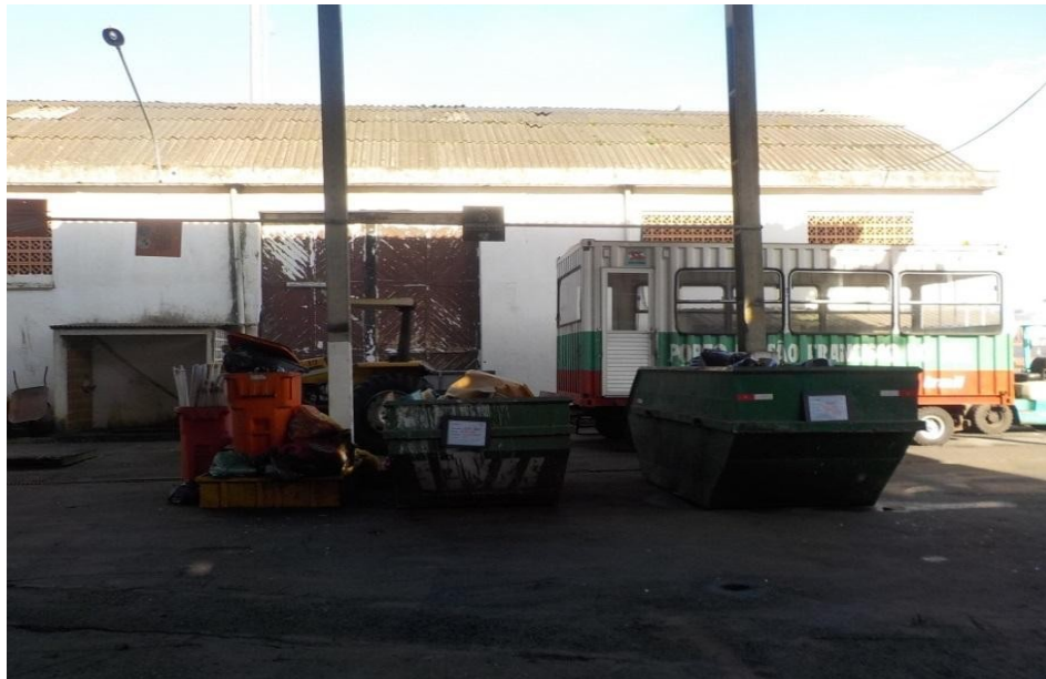
Figura 40- Central de resíduos
