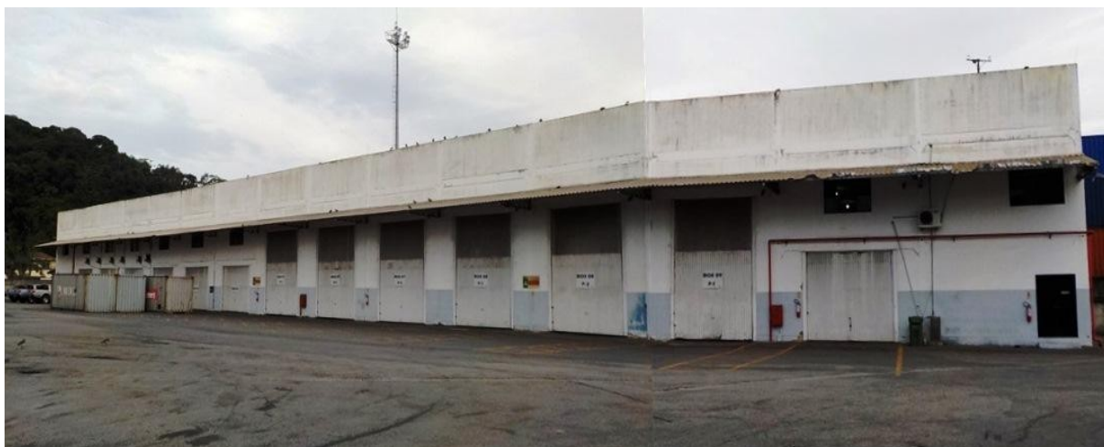
Figura 8 – Armazém em Concreto
