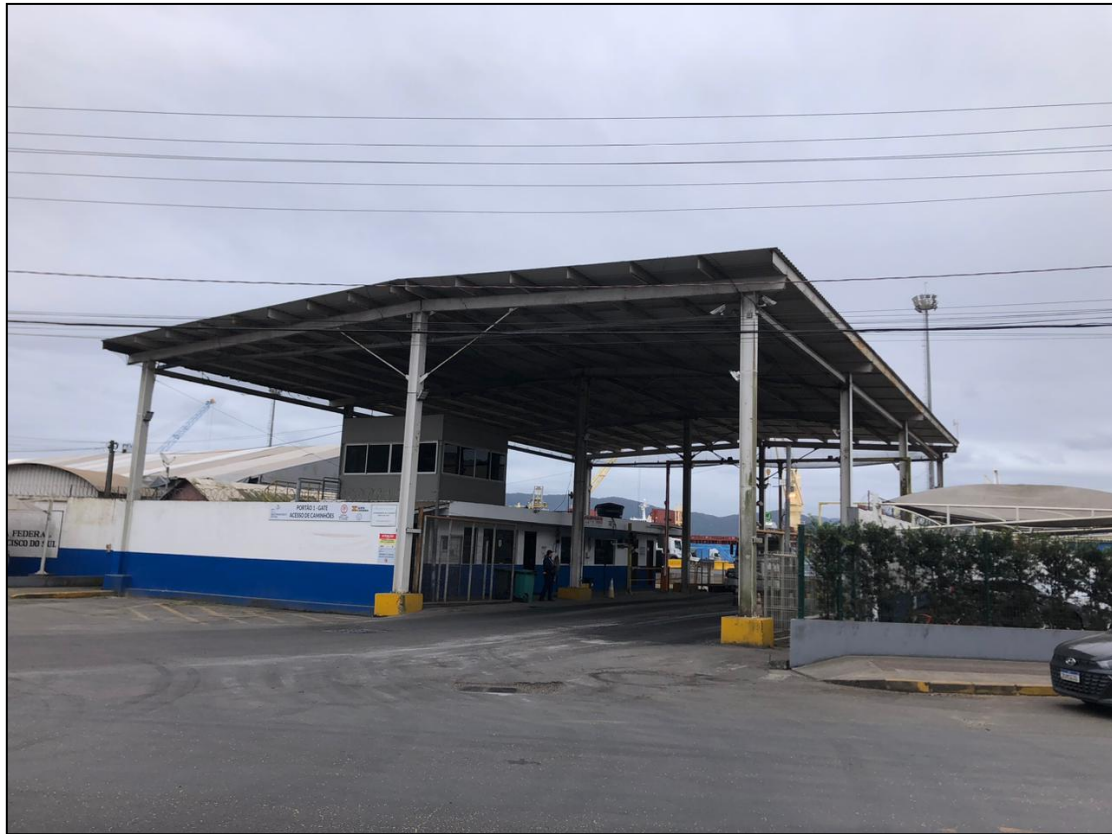
Figura 300. Gate A: Portão de acesso de veículos pesados e leves na área operacional da Administração do Porto de São Francisco do Sul.
