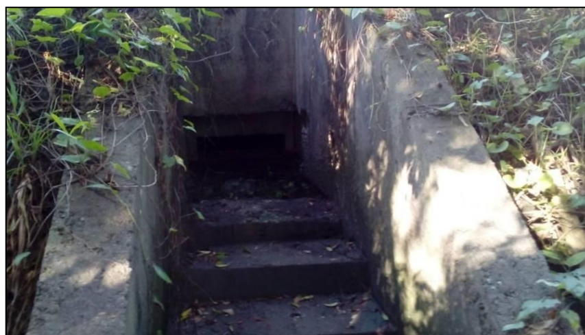
Figura 279. Caixa de drenagem pluvial, sem a presença de efluente, próximo ao rio Pedreiras - # 3.1 - mês de fevereiro de 2017.
