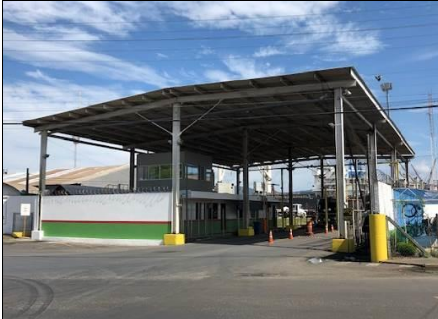
Figura 324. Gate A: Portão de acesso de veículos pesados e leves na área operacional da Administração do Porto de São Francisco do Sul.
