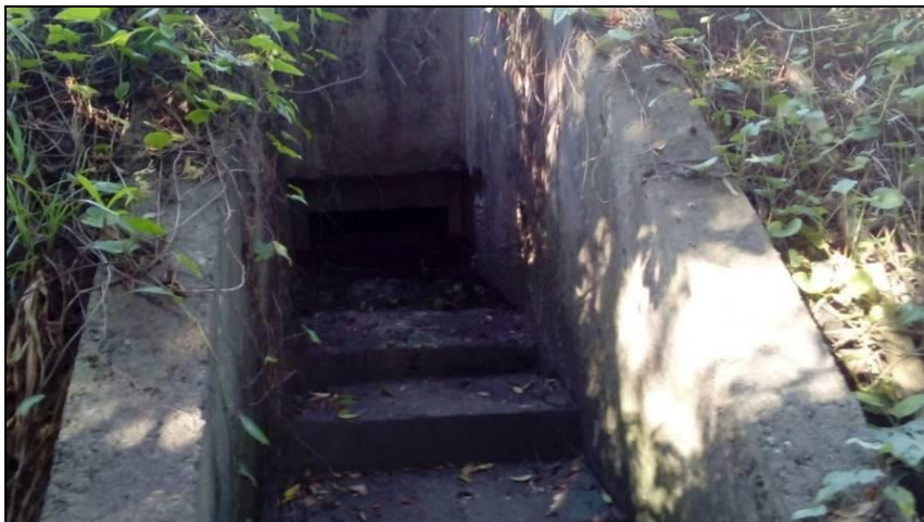
Figura 299. Caixa de drenagem pluvial, sem a presença de efluente, próximo ao rio Pedreiras - # 3.1 – mês de fevereiro de 2017.
