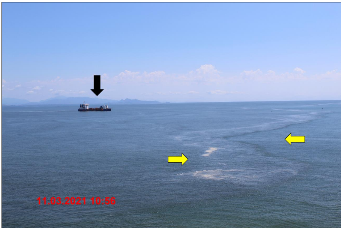
Figura 446: Lelystad identificada pela seta em preto, dragando em linhas um trecho do canal externo, a diante apontada pela seta em amarelo a pluma decorrente da frente oceanográfica.
