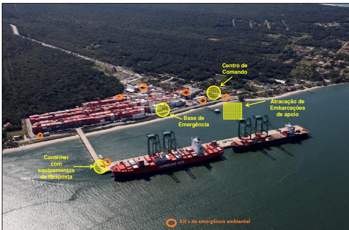
Figura 13. Porto Itapoá, estruturas de apoio com localização dos equipamentos de combate a emergências.
